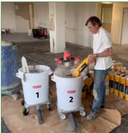
4- Transférer le mélangeur dans le « MIX PERFORMER 2 », le lancer et verser 2 sacs de ragréage.
