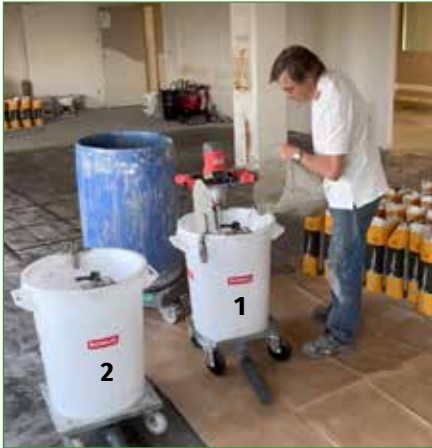
1- Remplir la station « MIX PERFORMER 1 » avec environ 10 L d'eau.
