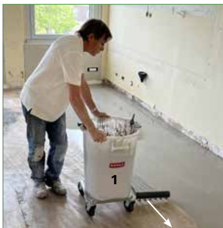
7- Avancer naturellement, le ragréage s'écoule en appliquant la bonne quantité qui s'autonivelle. Lorsque le débit devient plus lent tourner la manette en position 2 jusqu'à ce que le bidon soit vide.
