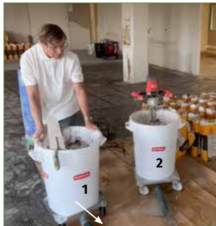
5- Pendant que le « MIX PERFORMER 2 » est en train de réaliser le mélange, prendre le « MIX PERFORMER 1 » et se diriger vers la zone d'application.
