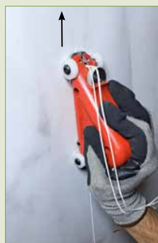
Chanfreinage sur un mur PVC d'un système douche.
