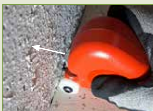
4-Chanfrein du dernier cm avec la lame arrière en retournant l'appareil.
