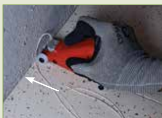
3-Chanfreinage jusqu'au mur.
