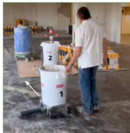
8- Revenir vers le « MIX PERFORMER 2 », recommencer les étapes de préparation sur le « MIX PERFORMER 1 ». Et pendant que ce fait le mélange, partir avec le « MIX PERFORMER 2 » pour appliquer le ragréage. Répétez le roulement jusqu'à la fin de chantier.
