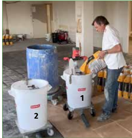
2- Mettre en route le mélangeur et verser 2 sacs de ragréage. Laisser le batteur tourner jusqu'à obtenir un mélange homogène.
